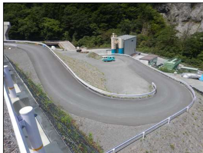
工事用道路の仮舗装
