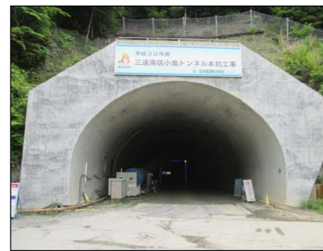
②トンネル本坑工事
