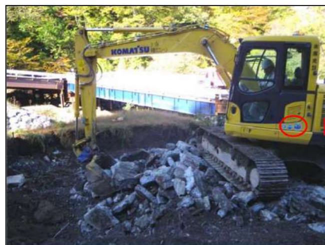
排ガス対策型・低騒音型建設機械
