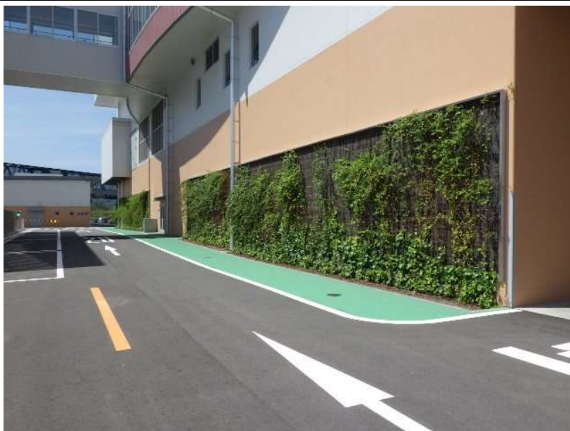
工場棟壁面緑化 緑化部分南側
