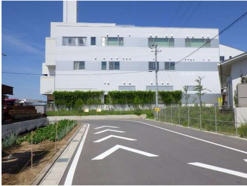
管理棟壁面緑化 南西側より
