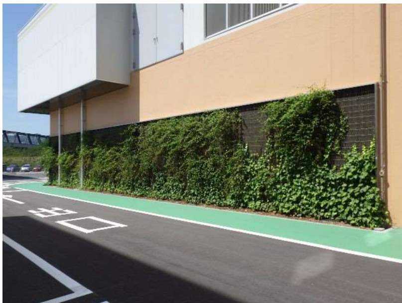
工場棟壁面緑化 緑化部分北側
