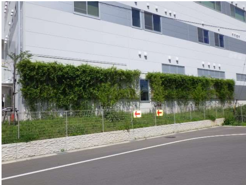
管理棟壁面緑化 西側より
