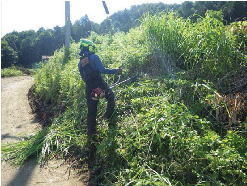
写真区分: 施工状況写真 工種: 準備工 種別: 伐木・除根 細別: 伐採 写真タイトル: 除草作業状況 撮影箇所: 現場にて
