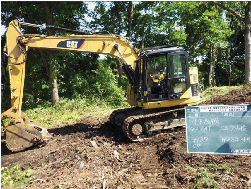
写真区分:使用機械写真 工種:バックホウ(バケット ハンド型) 種別:313DCR 写真タイトル:使用機械(排 対型・低騒音型) 撮影箇所:現場にて
