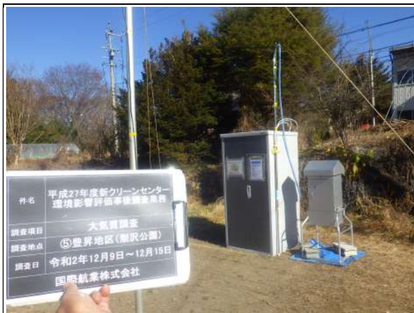
写真 3.2.1 機材設置状況（一般環境大気質）
