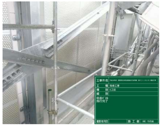
写真 3. 2. 10 吸音材の設置完了状況
