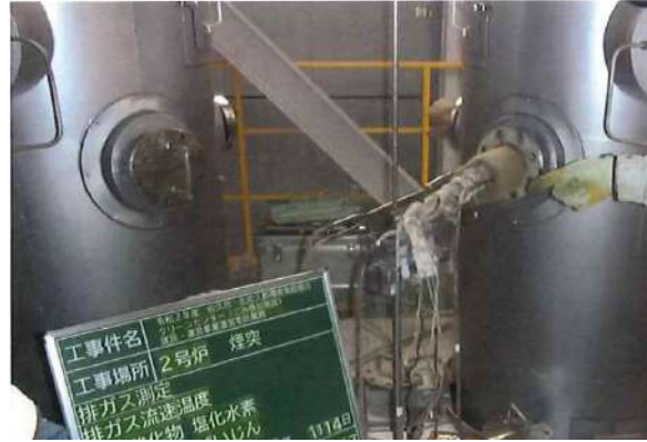
写真 3. 2. 6 排ガス濃度の監視の様子
