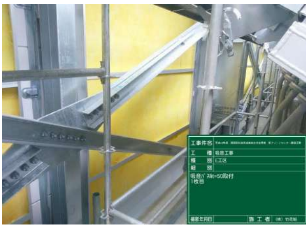
写真 3. 2. 9 吸音材の設置状況
