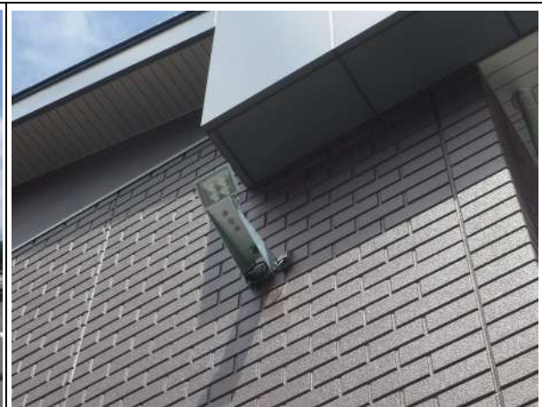
写真 3.2.24 夜間照明設置の様子②
