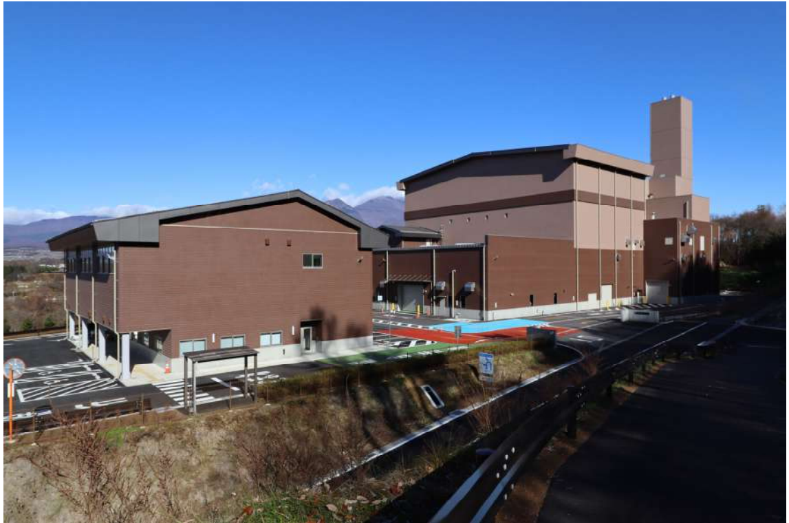
写真 1.5.2 施設南側 [左：事務所棟 右：工場棟、煙突] (令和2年11月21日撮影)
