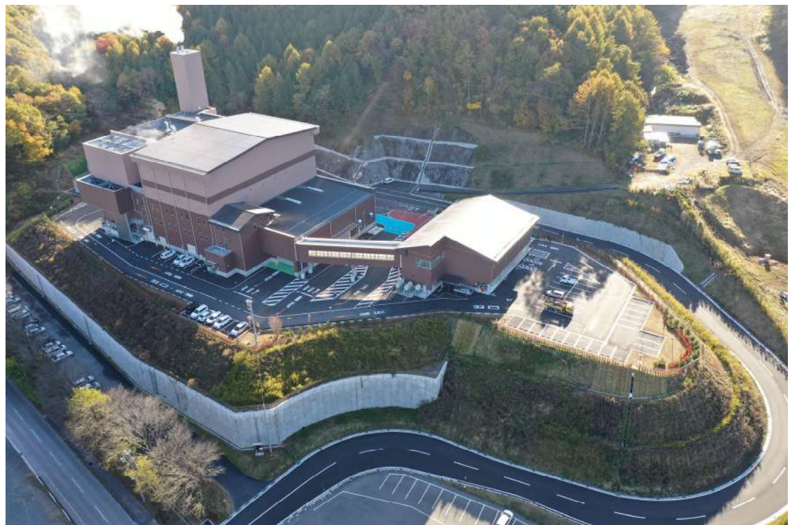
写真 1.5.3 施設西側 [左：工場棟、煙突 右：事務所棟] (令和2年11月4日撮影)
