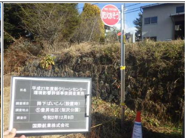
写真 3.2.2 機材設置状況 （一般環境大気質：降下ばいじん）
