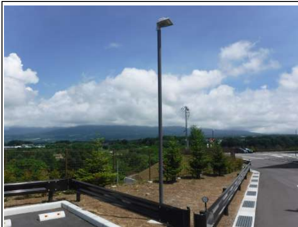
写真 3.2.23 夜間照明設置の様子①
