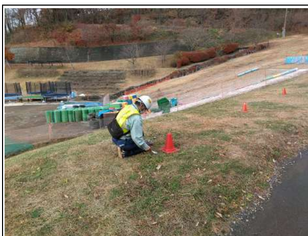
写真 4.1.1 土壌採取の状況
