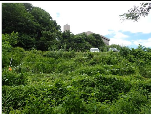
写真 3.1.107 平尾用水左岸法面の状況(7月)
