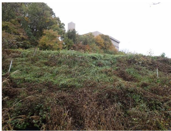
写真 3.1.109 除草作業前の状況(11月)
