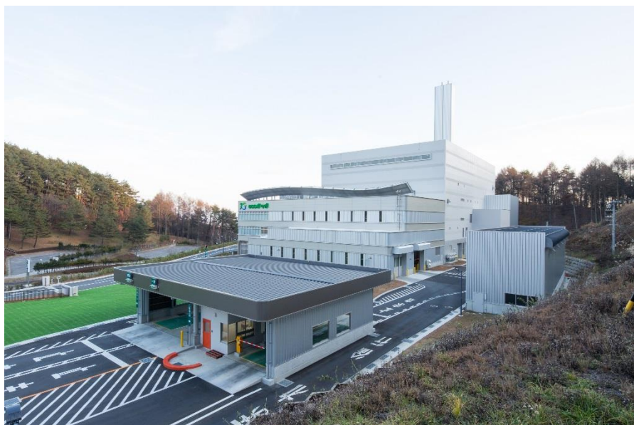
図1-3. 施設完成後の全体写真
