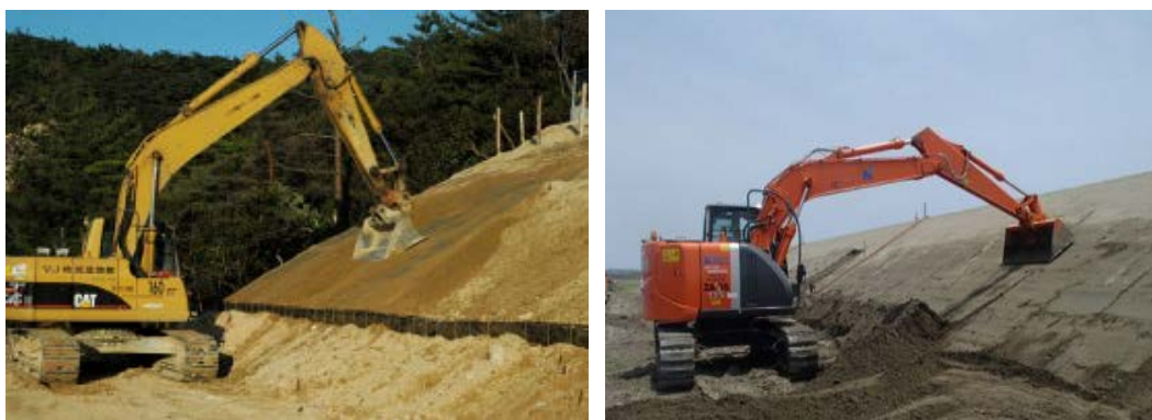
写真 1-6-7 盛土法面整形工事参考写真
