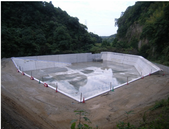
写真 1-6-4 防災工事参考写真（左：調整池設置工事、右：暗渠排水管敷設工事）
