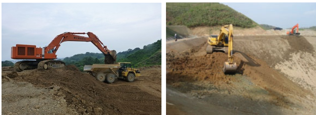
写真 1-6-6 造成工事参考写真
