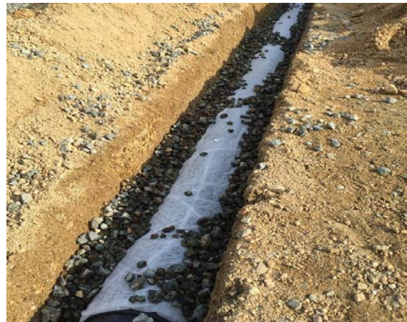
写真 1-6-4 防災工事参考写真（左：調整池設置工事、右：暗渠排水管敷設工事）
