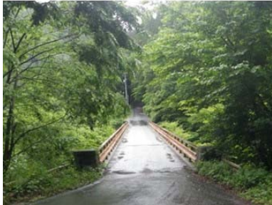
県道253号: 終点手前の小河内沢川に架かる橋梁の状況
