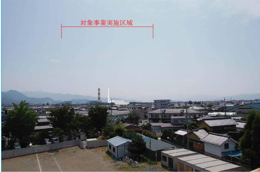
存在・供用時(繁茂期)
