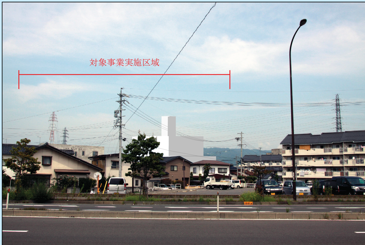
国道18号沿線からの景観
