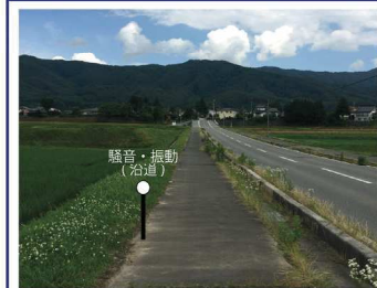
※騒音・振動(沿道)を測定
