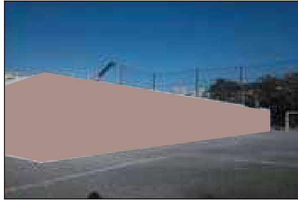
仮囲いの設置
