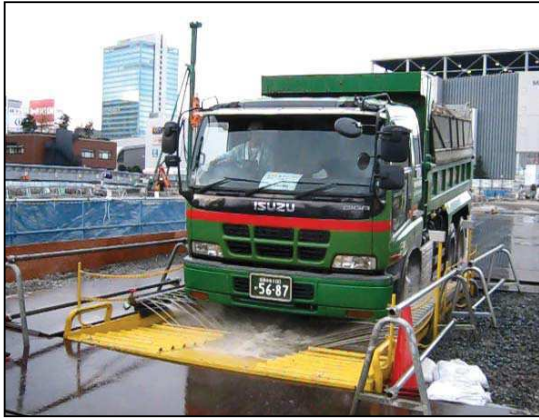
タイヤの洗浄状況
