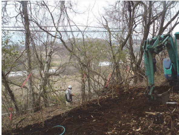
写真 4-1-21 移植先への移植完了
