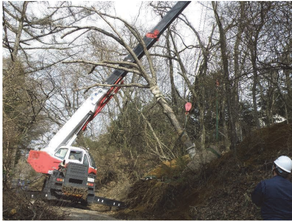
写真 4-1-1 自生地からの掘り出し作業
