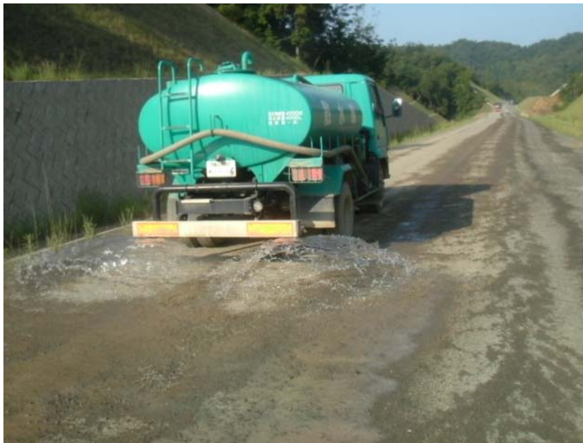
道路の散水・清掃状況
