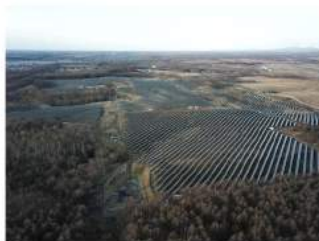
北海道中標津町に建設した30MWの 太陽光発電所
