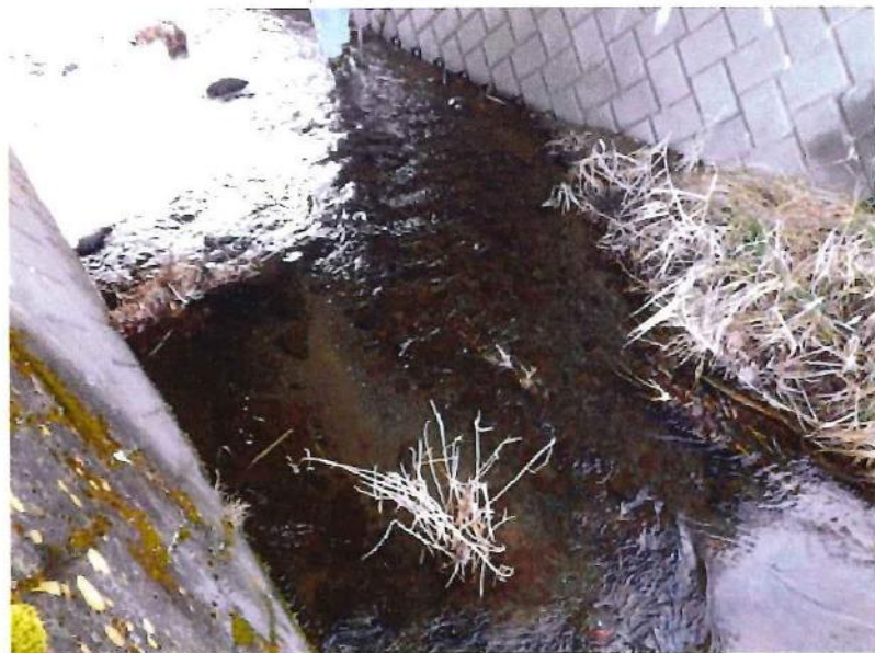
河床状況(12/22再調査) 上流から流れてきた 玉石が点在する。 (10～30cm程度)
