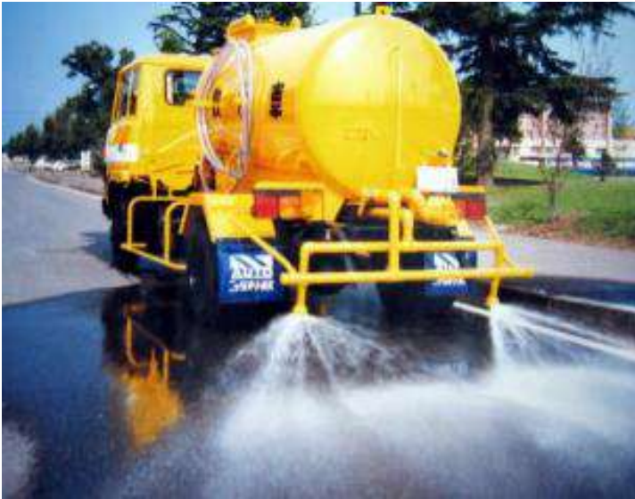
道路の散水・清掃状況
