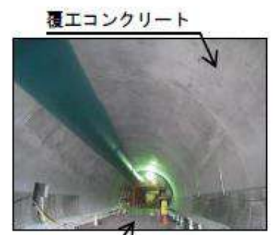
7.覆工・路盤コンクリート
