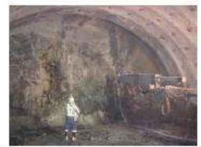
5.吹付けコンクリート
