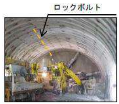
6.ロックボルト打設
