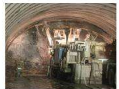
4.鋼製支保工建込
