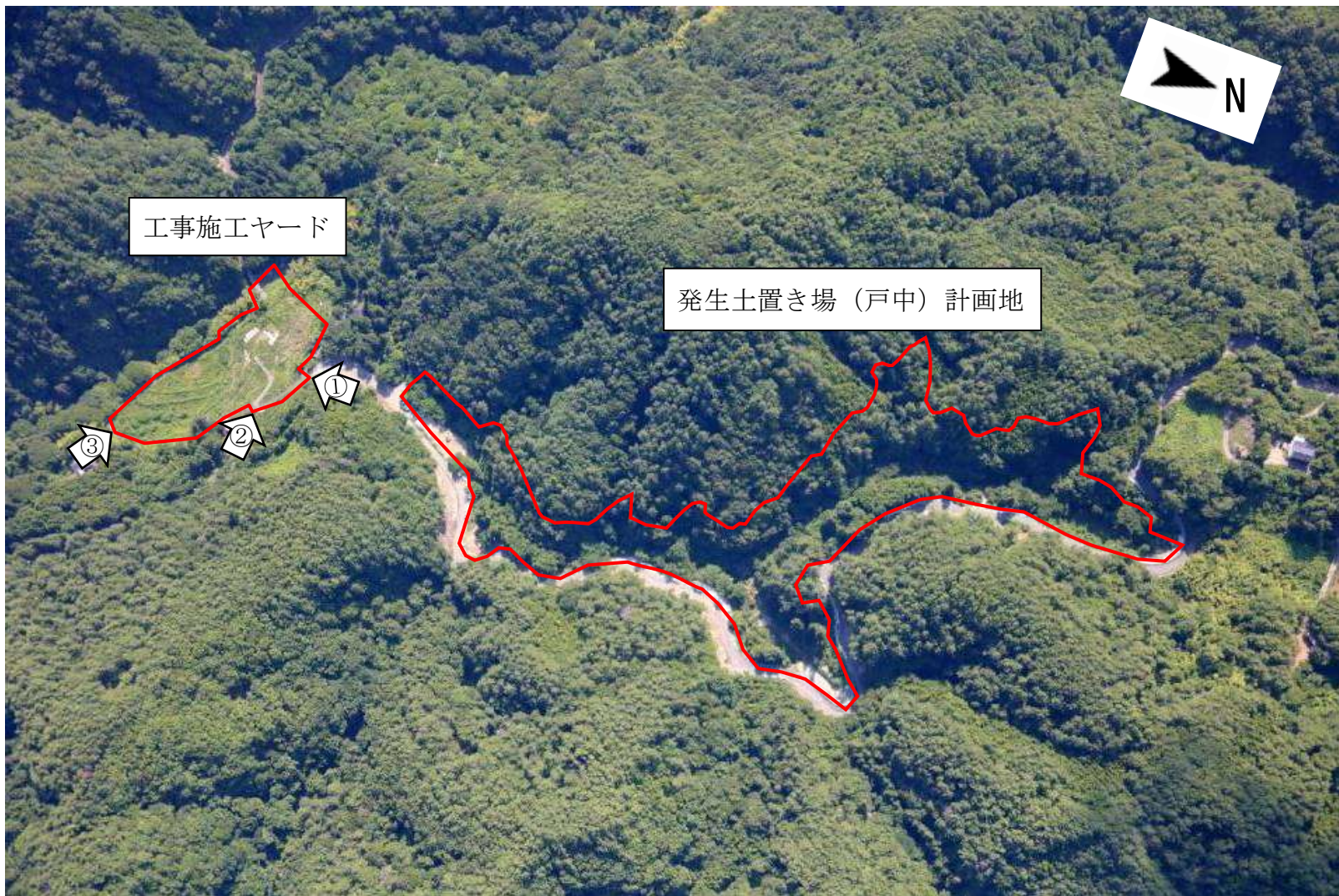
工事位置の現況 (上空から俯瞰する)
