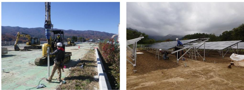
写真1.1.5-12 太陽光パネル設置工事のイメージ（左：架台設置、右：パネル設置）
