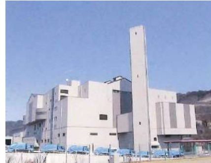
可燃ごみ処理施設
