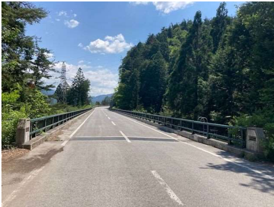
写真 5.5.1.3 わらび沢大橋
