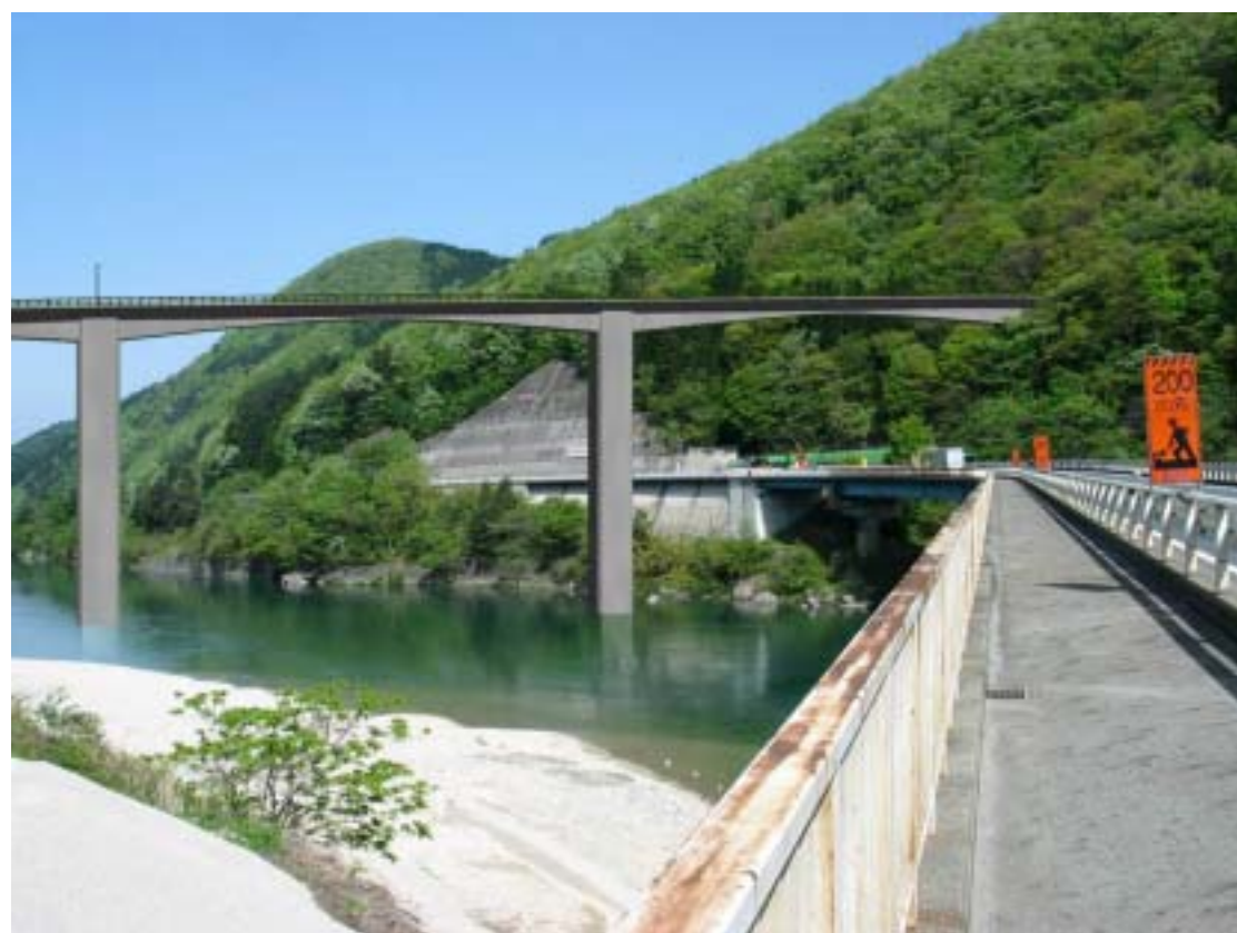
図 4. 13-1 固定眺望点 南木曾大橋(国道 19号)における現況と供用後の眺望状況の比較
