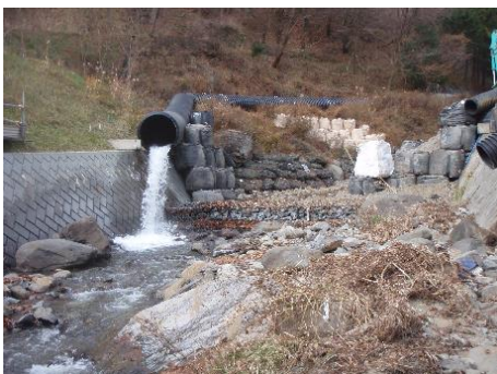
工事中の区間
