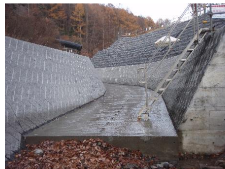
改修された区間
