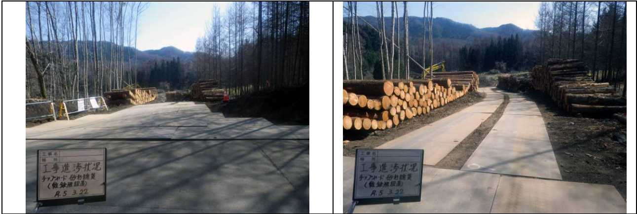
写真4-7：工事箇所や工事区域内での敷鉄板状況写真（令和5年3月22日撮影）
