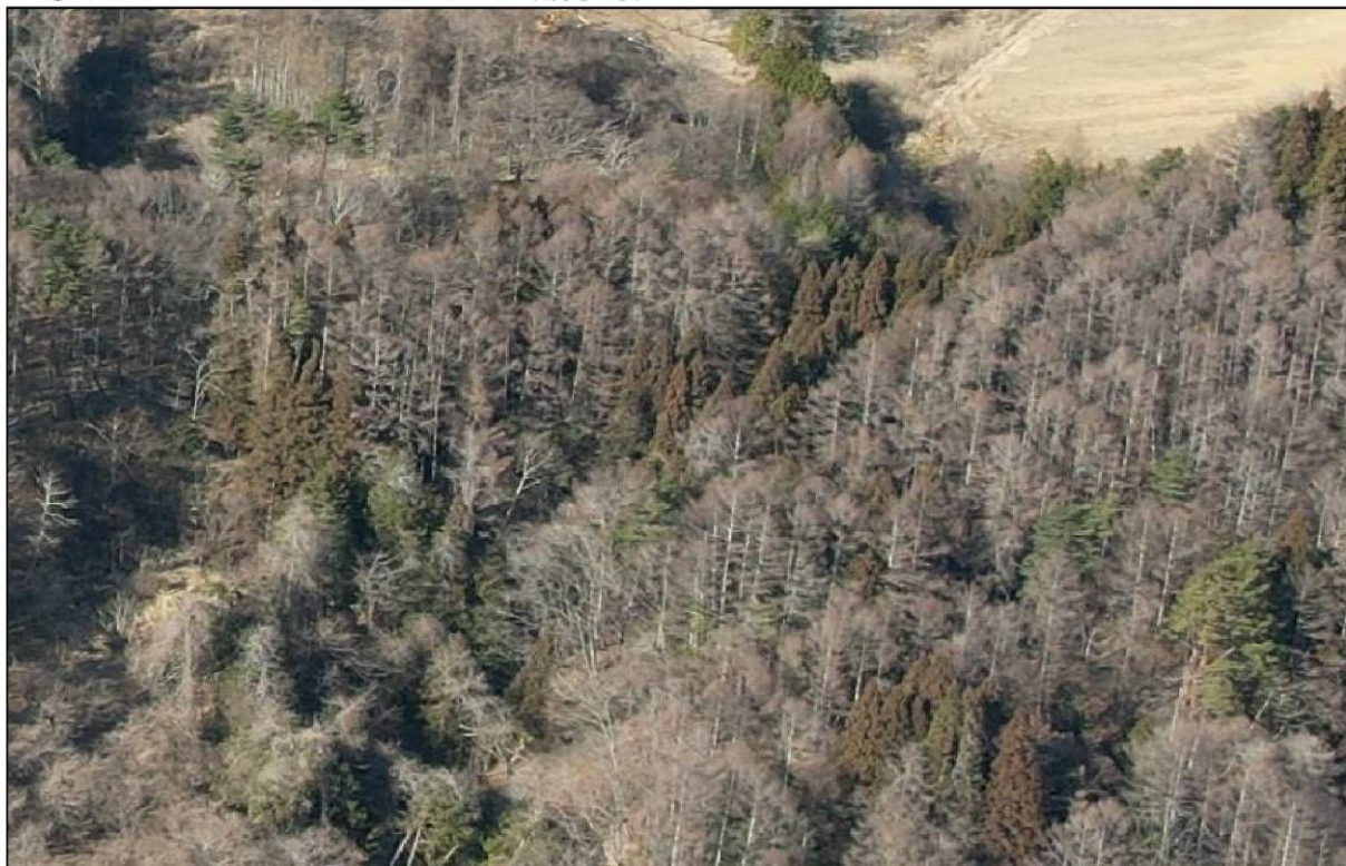
④チップヤード・No.7調整池まわり（着手前）
