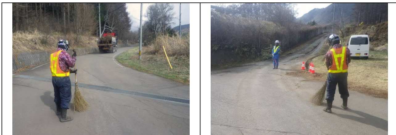
写真4-4：工事用車両出入口の路面清掃の写真（令和5年3月28日撮影）
