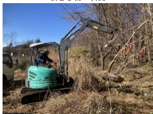
重機による移植株の運搬
