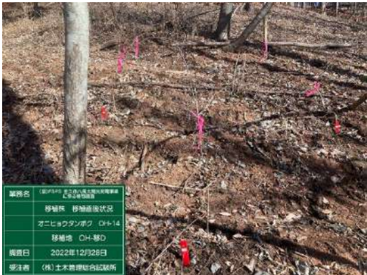
ラベル杭設置状況
