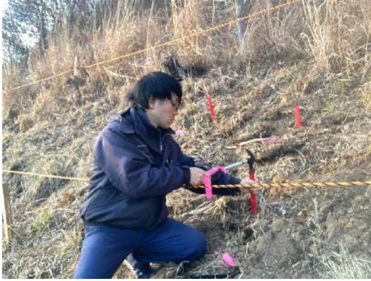
マーキング打設
