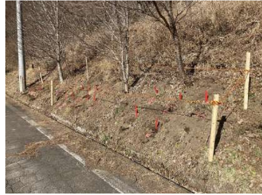
囲いの設置状況
