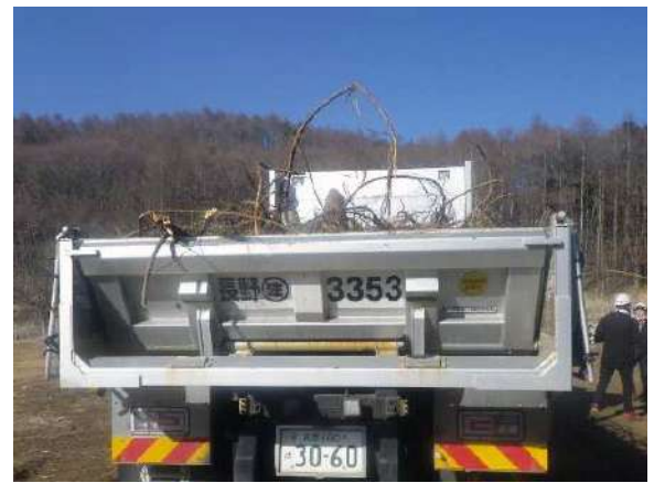
伐採木の場外搬出状況
