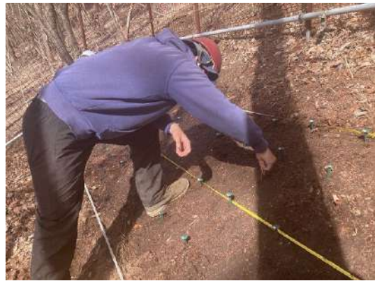
ラベル杭設置
