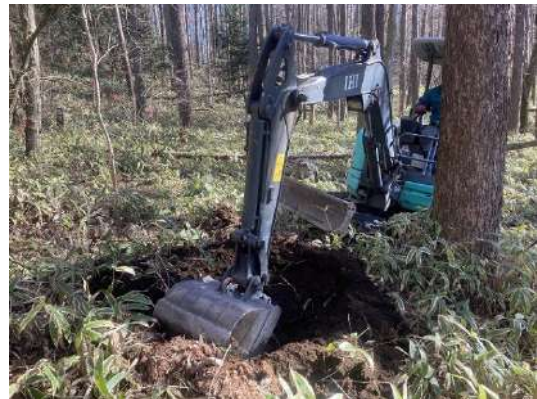
重機による移植箇所の穴あけ
