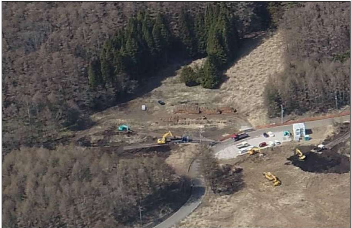
写真 4. 3-2(2) 工事の進捗状況写真（No. 2 調整池まわり：令和 5 年 3 月 31 日時点）
