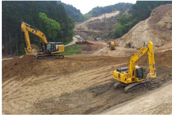
写真1.5-7 造成工事のイメージ
