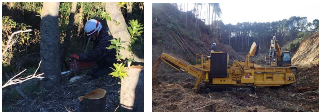
写真1.5-6 伐採工事のイメージ
