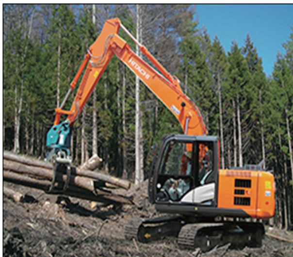
写真 1-6-5 伐採工事参考写真
