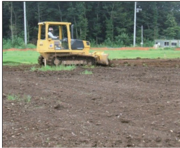
写真 1-6-6 造成工事参考写真
