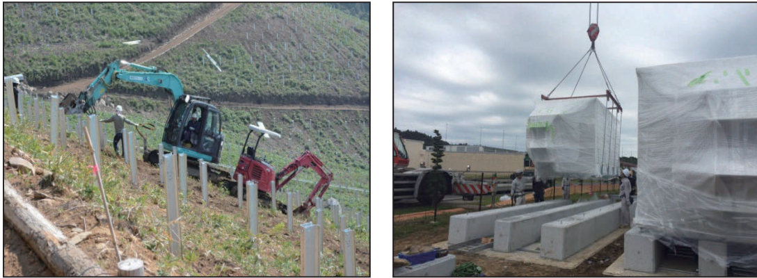
写真 1-6-8 施設建設工事（左：架台設置工事 右：キュービクル据付）
