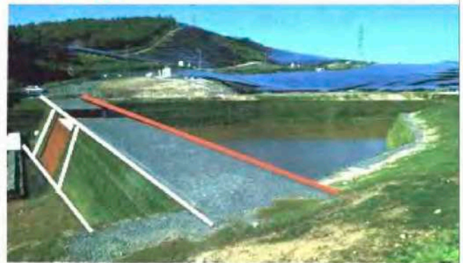
ダブルウォール工法による調整池(メッシュ分銅九重ローラー、養生機埋設)
