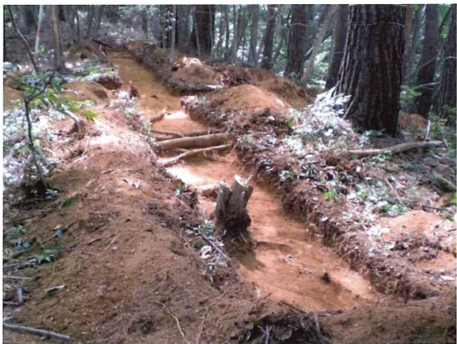
東西方向トレンチ（東から撮影）
