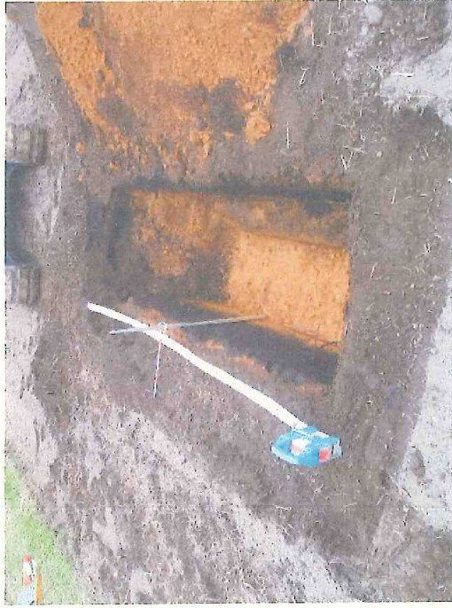
No.7 トレンチ2 全景 (北西から)
