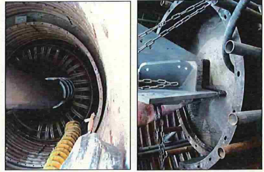
基礎材据付と柱体部の
