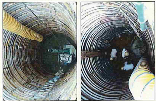
鋼製支保工を土留めに
