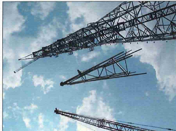
鉄塔腕金の取付け
