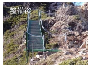
【老朽化した鋼橋と手すりを改修】
