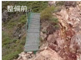
【老朽化した鋼橋と手すりを改修】
