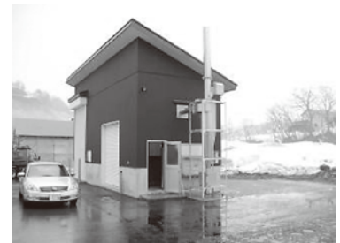
栄村北野天満温泉木質チップボイラー
