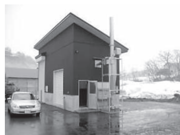
栄村北野天満温泉木質チップボイラー
