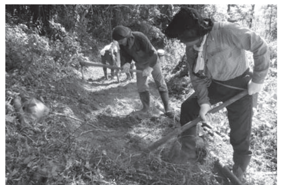
住民協働による遊歩道の整備
