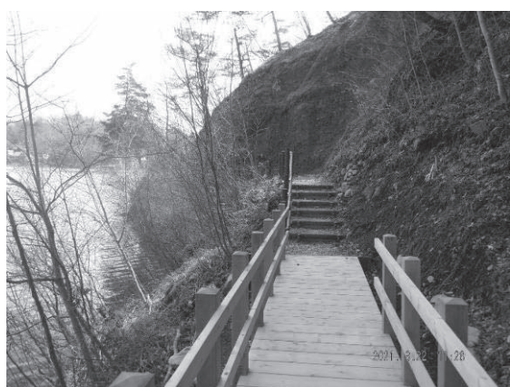
遊歩道整備（小海町）
