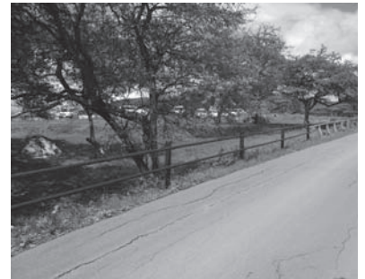
高ボッチ高原園地 柵改修 (塩尻市)
