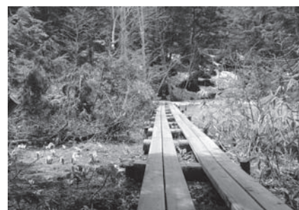
木道改修（山ノ内町志賀高原道路）
