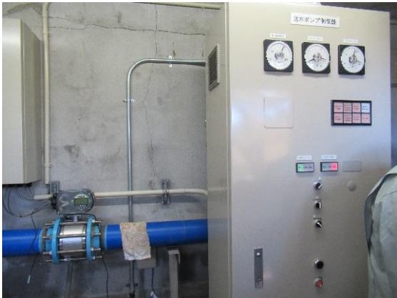
●取水設備② (送水ポンプ・制御盤)
