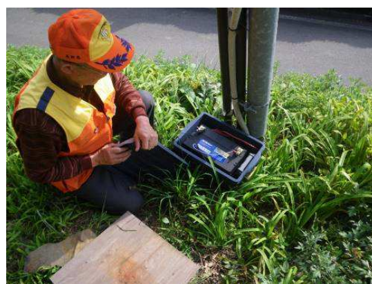
サル接近通報装置メンテナンス
