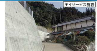
デイサービス施設 大分県豊後大野市余所萩地区 急傾斜地崩壊防止施設 (重力式待受擁壁)
