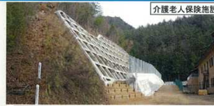
介護老人保険施設 長野県安曇野市有明地区 急傾斜地崩壊防止施設 (重力式待受擁壁)
