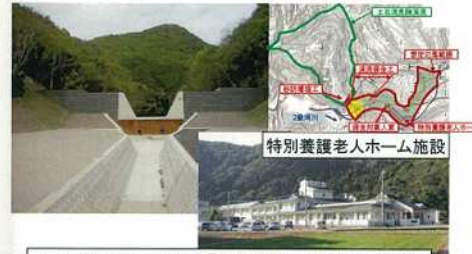
特別養護老人ホーム施設 和歌山県東牟婁郡串本町二色地内 土石流対策施設 (砂防堰堤及び溪流保全工)
