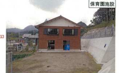
保育園施設 宮崎県宮崎市鏡洲地区 急傾斜地崩壊防止施設 (重力式擁壁)
