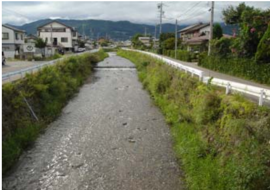
現況写真(他力橋上流付近)
