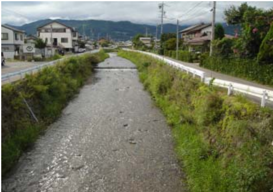
現況写真(他力橋上流付近)
