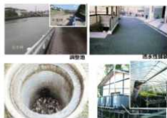
雨水貯留浸透施設の例
