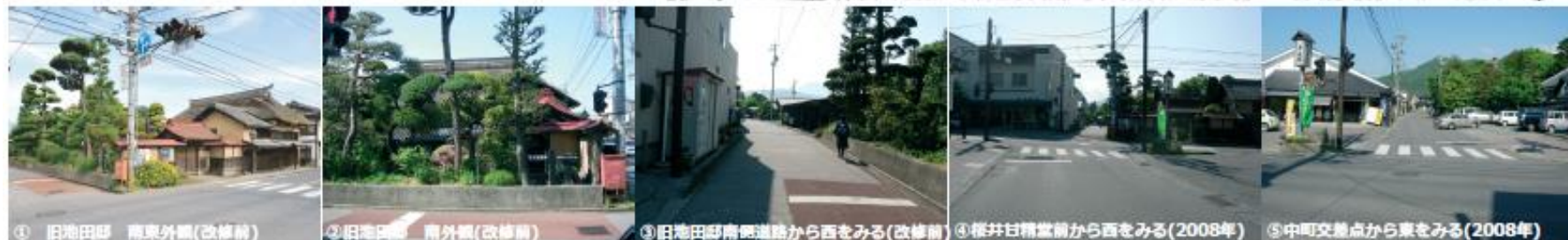
① 旧池田邸 南東外観(改修前)
