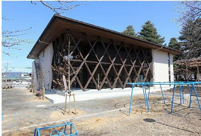
■南側外観 格子状の壁を設け、木の力強さと特徴のある外観をつくっています。また、この部分はスクリーンとして、公園と建物を緩やかに結びつけています。
