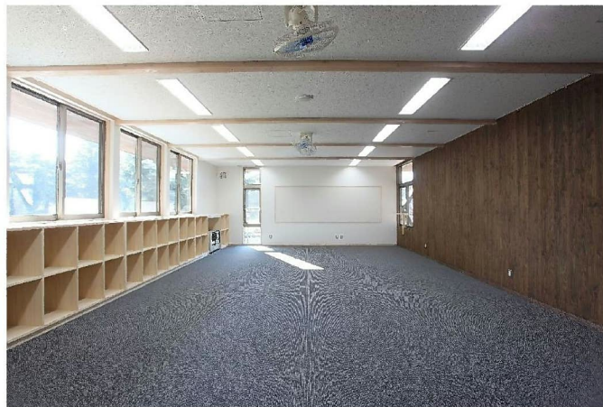
■2階クラブ室内観 外壁の杉板が内部空間につながります。また、梁を表して用いて、木造建築らしさを表しています。また、作り付けの家具は無垢材でつくっています。
