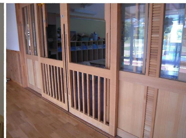
保育室出入口 木製框戸
