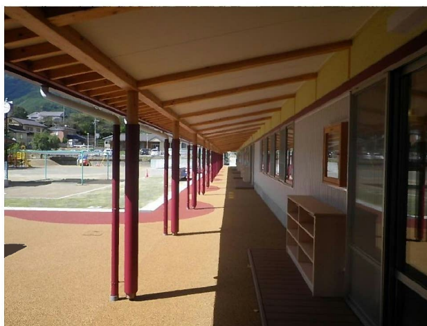
南面 テラス 柱・桁・垂木・梁 木製下駄箱 丸柱（赤）は防水のために鉄板を巻きつけた
