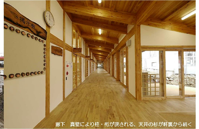
廊下 真壁により柱・桁が現される、天井の杉が軒裏から続く
