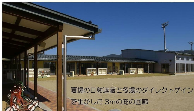
南側（園庭側）全体 断熱サンドイッチパネルと断熱サッシによる外断熱の外皮
