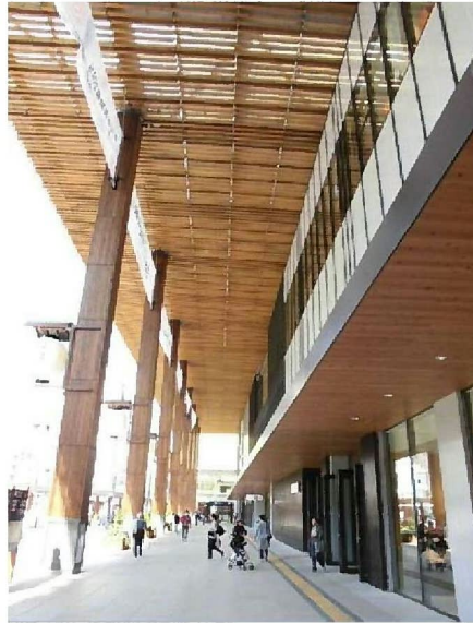
庇の下の通路の様子
