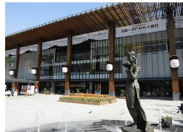
広場の植栽と門前回廊
