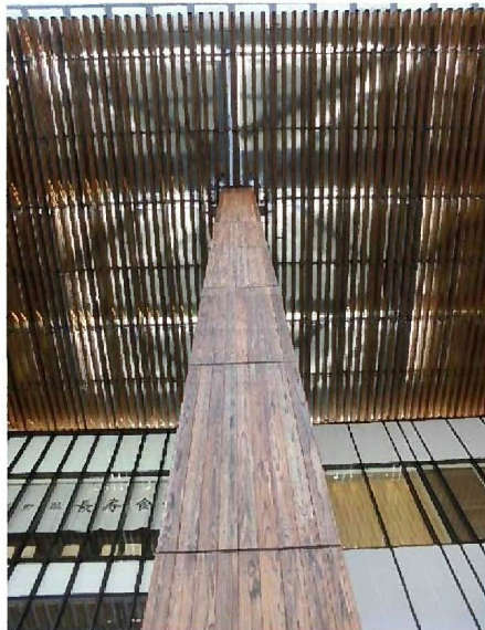
柱と庇を見上げる
