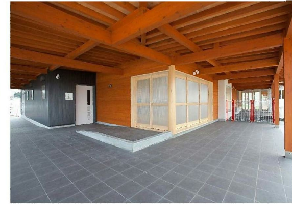
【多目的ホール出入口(ポーチ③)】
