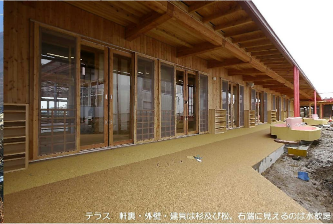
テラス 軒裏・外壁・建具は杉及び松、右端に見えるのは水飲場
