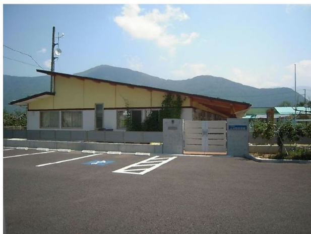
西面外観 正面出入口
