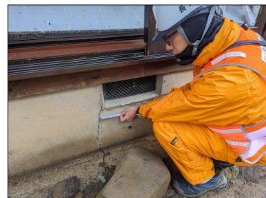
【基礎の被害調査】 ひび割れ等の基礎の被害や 土台との接合状況を調べます
