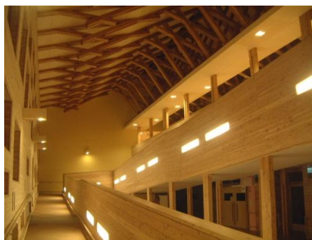
県産木材を活用した木造での改築を行った稲荷山養護学校（千曲市）
