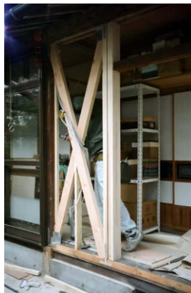
耐震改修(住宅)
