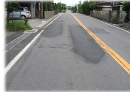
（舗装修繕（穴埋めなど））
