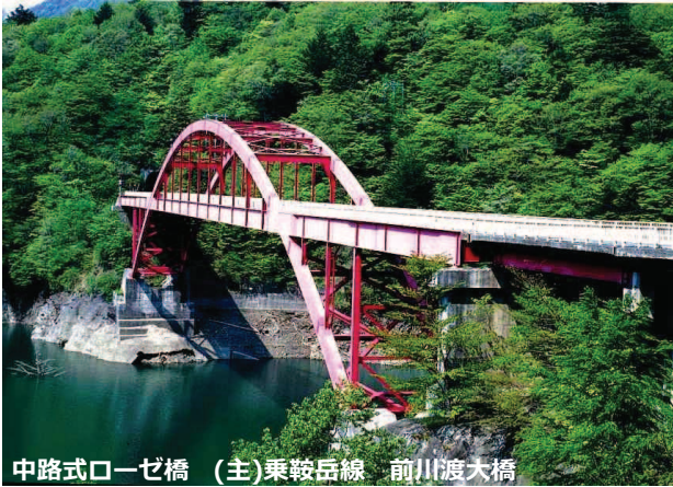
中路式ローゼ橋 (主)乗鞍岳線 前川渡大橋
