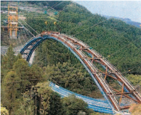
特殊橋梁工事(例:ケーブルエレクション工法による橋梁架設)
