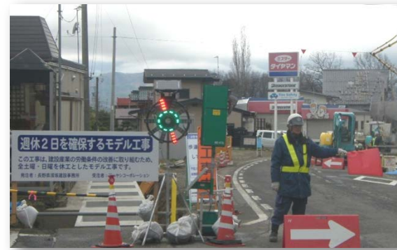
モデル工事の掲示板と実施状況
