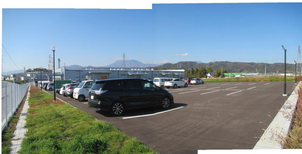
② 森林地域の縮小区域(事業所棟ほか新築工事)
