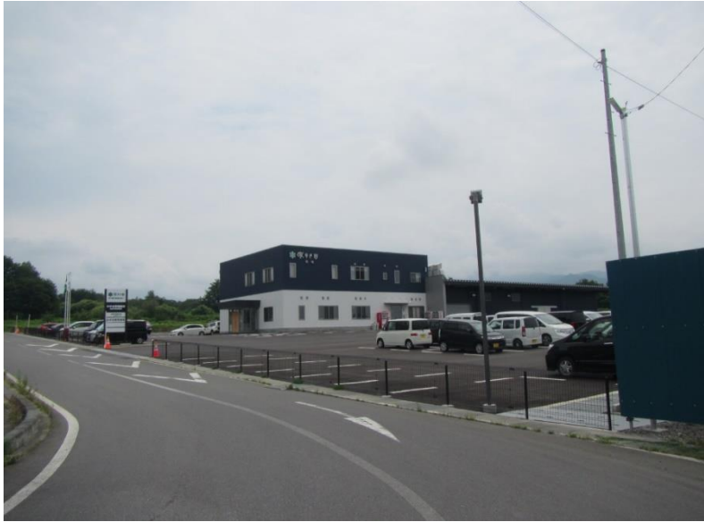
① 森林地域の縮小区域(事業所棟ほか新築工事)
