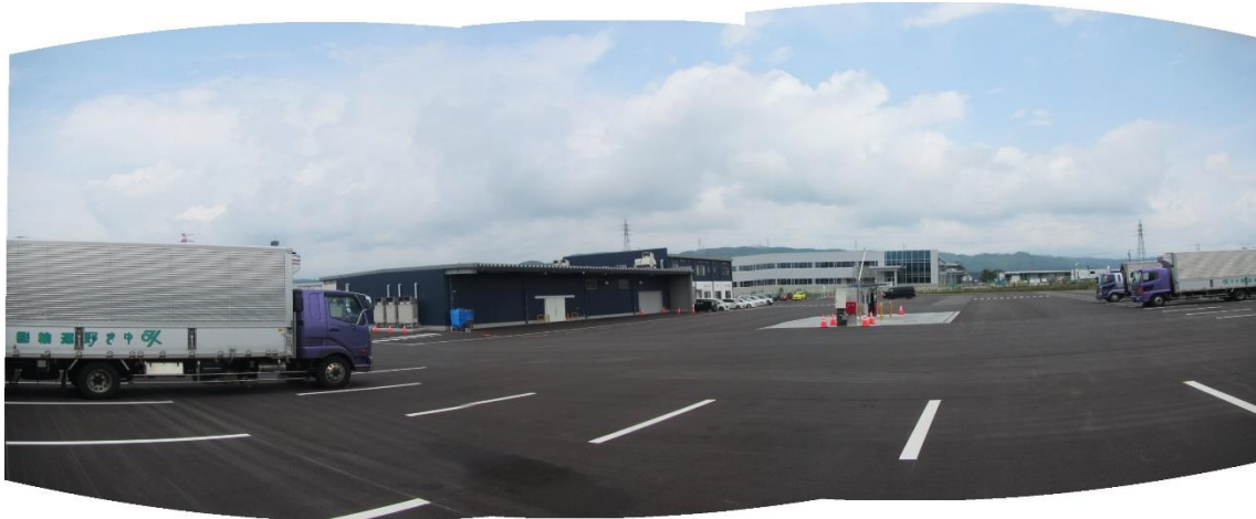
② 森林地域の縮小区域(事業所棟ほか新築工事)
