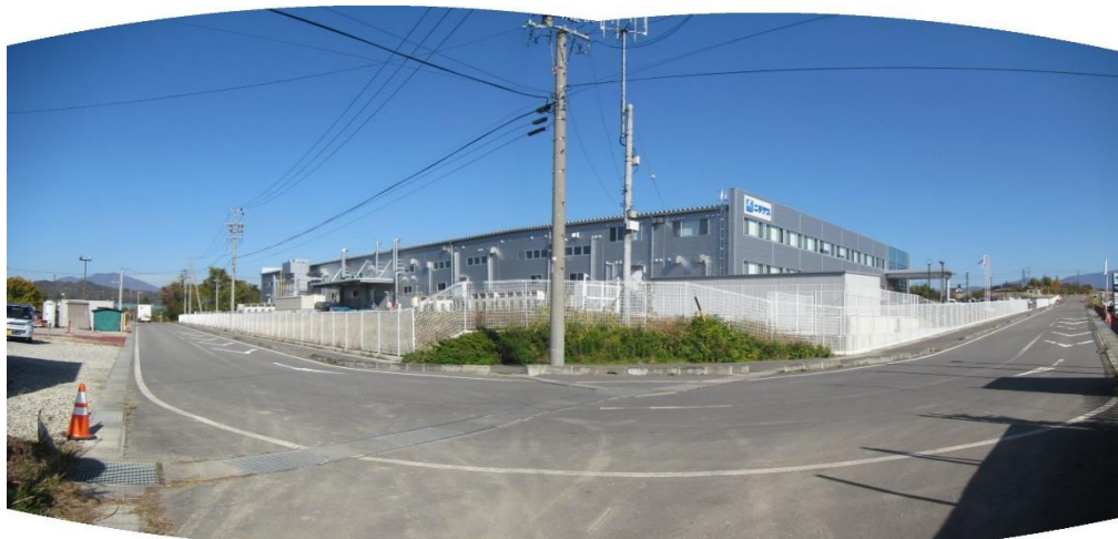
① 森林地域の縮小区域(事業所棟ほか新築工事)
