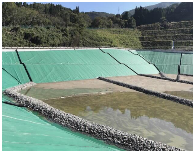
② 森林地域の縮小区域(埋立エリア底部に設置された暗渠工)
