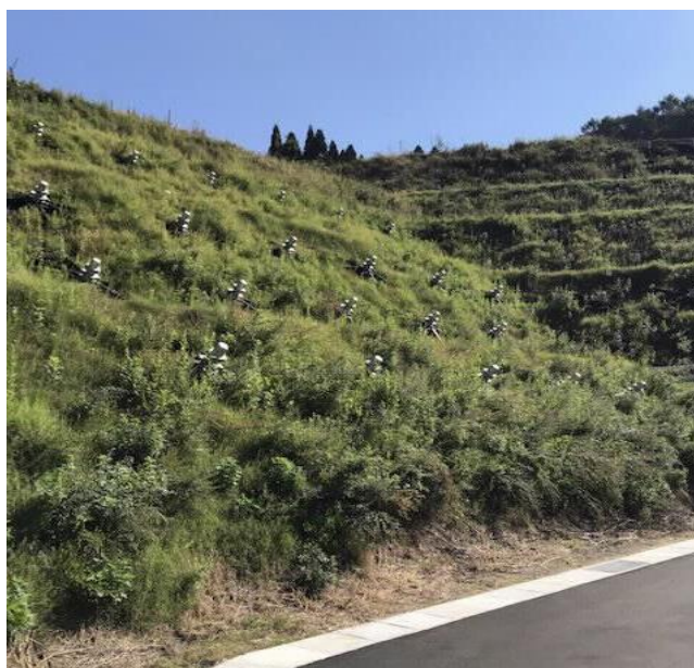
③ 森林地域の縮小区域(法面の緑化及びアンカー工)
